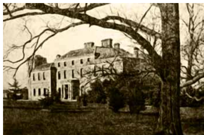
Canwell Hall in una foto d'epoca, prospetto occidentale
