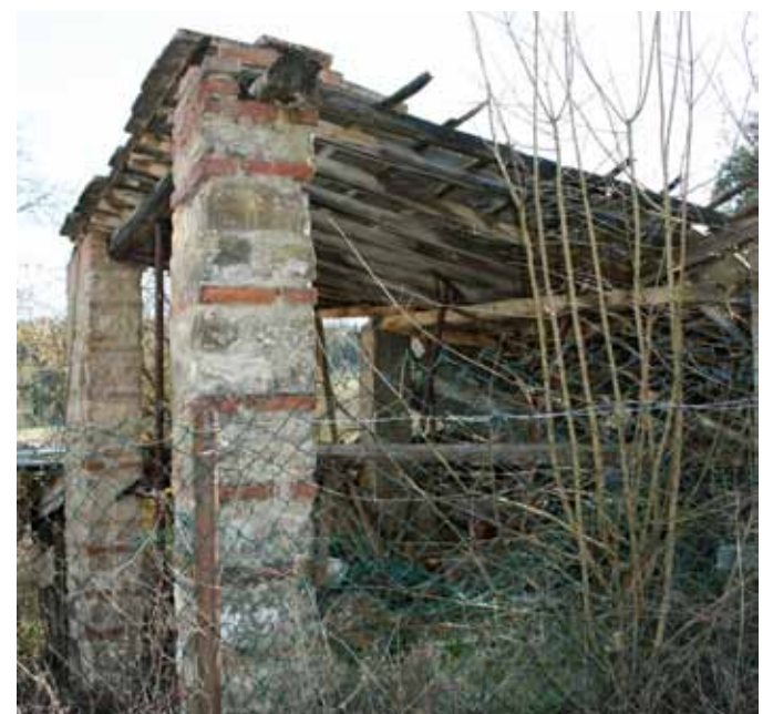
Gli originari lavatoio e tettoia posti all'Occidente della casa colonica del Mulinuzzo
