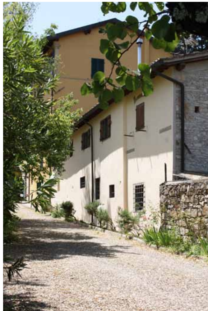
Il Cerretino, due scorci dell'edificio
