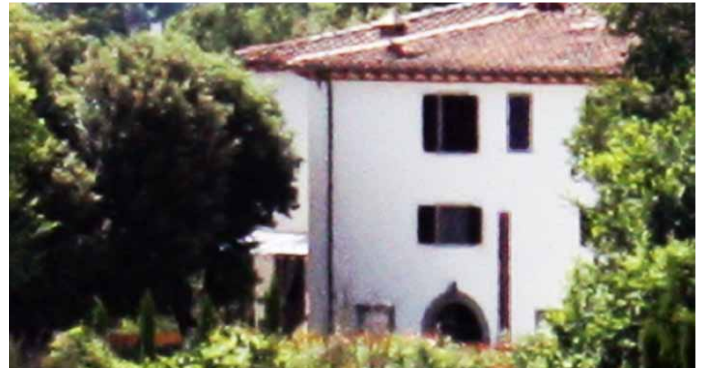
La villa già dei Lawley e poi dei Morpurgo come si presenta attualmente, frazionata in più unità residenziali, e particolare di essa e del portale centinato che vi si trova, risalente al XVII secolo
