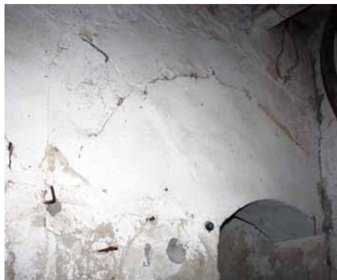
Particolare dell'ingresso centinato settecentesco alla tinaia nordorientale, poi ridotto in ampiezza
