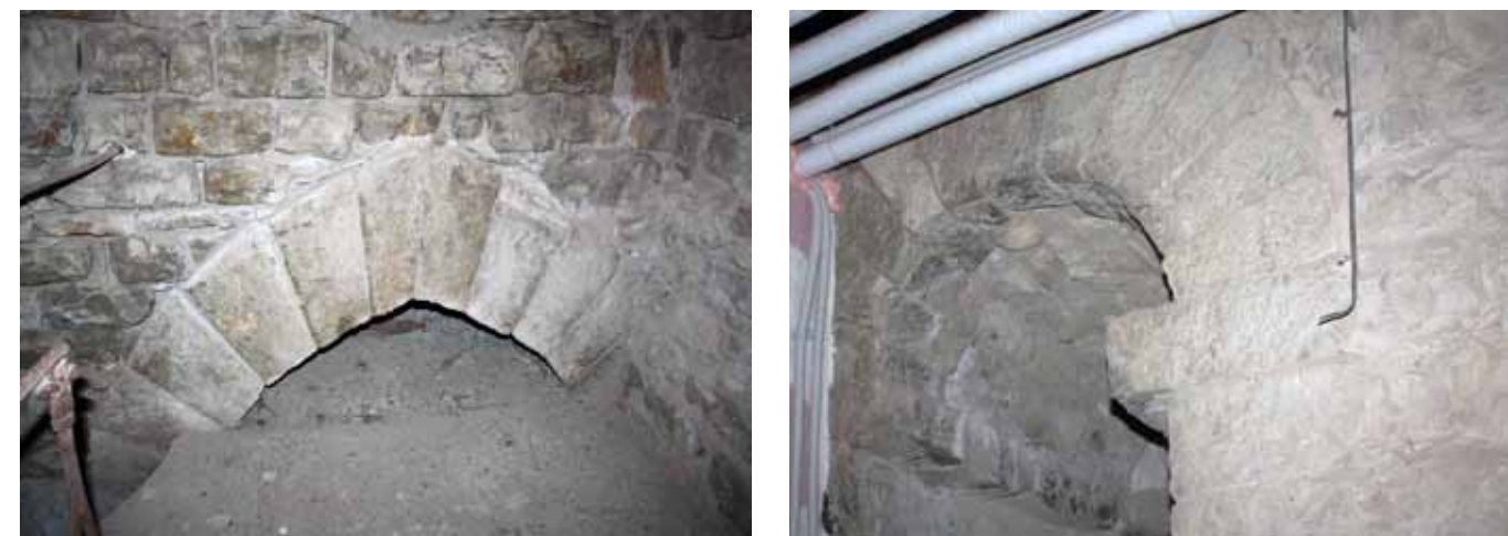
Vedute interne del supersite settore medioevale del castello di Montauto e particolari delle mostre di alcune porte e finestre
