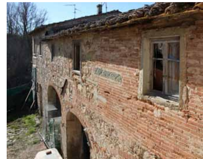
Scorcio della tamponatura dell'originaria altana al primo piano, trasformata in stanze
